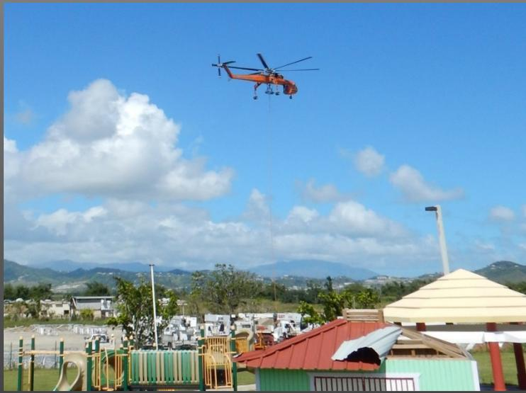
Hauling Concrete to pour a base for a new power pole
